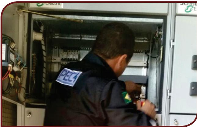
**Compressão dos terminais do transformador**
