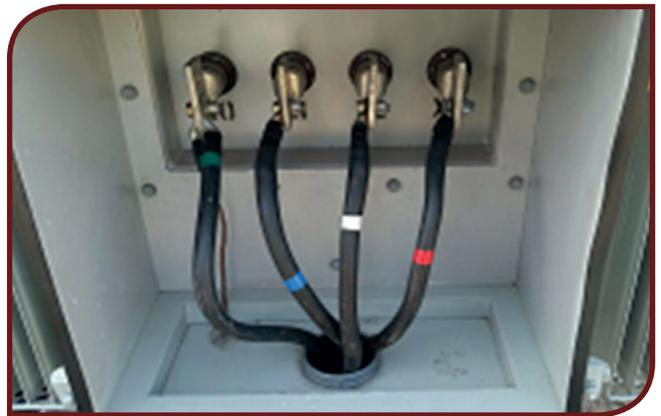
**Compressão dos terminais dos cabos do CCM**
